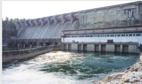
Нами выполнено обследование сооружений Мамаканской ГЭС. Получено рекомендательное письмо.
